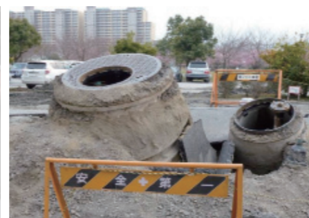
〔図3〕災害用耐震性貯水槽の被害
